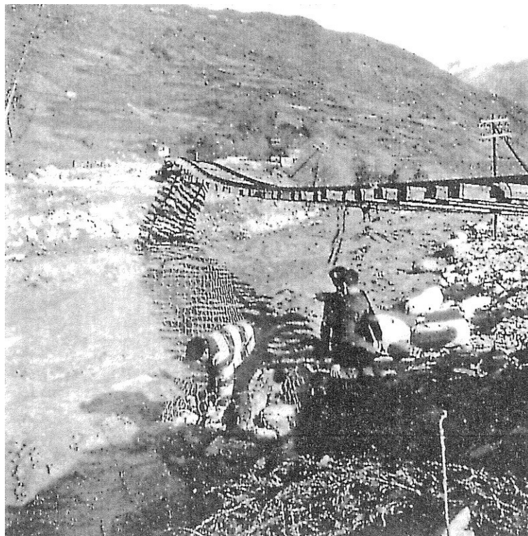
Illustration 12: dégât de la crue du 16 novembre 1963
