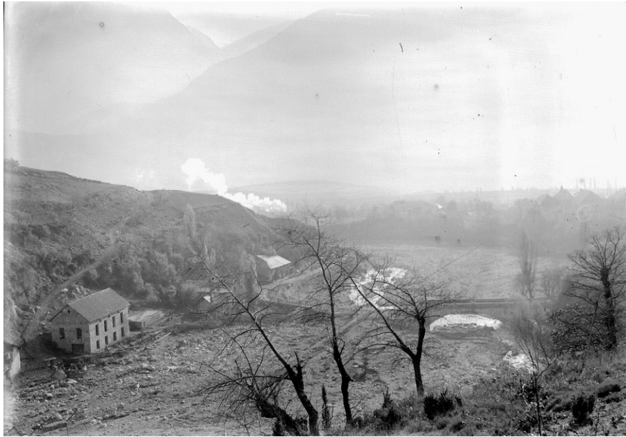
Illustration 9: dégât de la crue du 28 septembre 1928 au niveau de la RN 94
