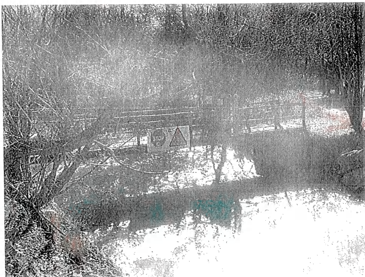
Passerelle piétonne de la route départementale 38b
